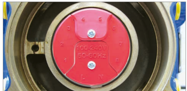
Fig 7.15 Bloc de jonction normal
