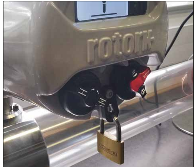
图 7.2. IQ 控制旋钮锁定在 "远程" 位置
