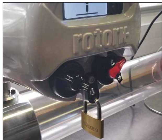
Fig 7.2. Sélecteur de commande de l'IQ3 verrouillé en mode À distance
