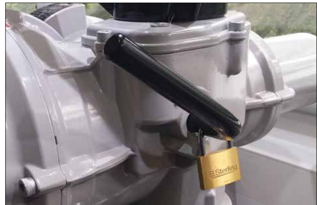
Fig 7.1. Verrouillage du levier manuel-auto de l'IQ3
