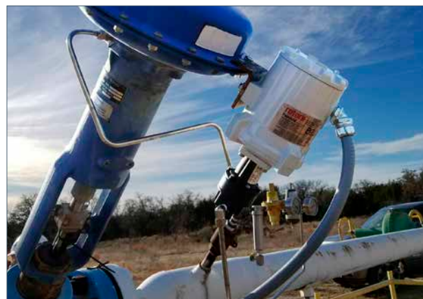
PAX1 установлен как регулятор на регулирующем клапане природного газа
