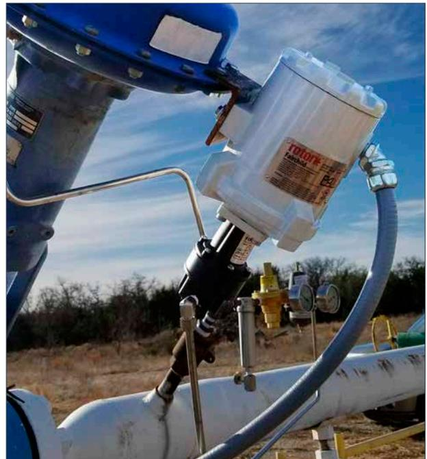
PAX<sub>1</sub> instalado em gasoduto de gás natural, como piloto da válvula de controle
