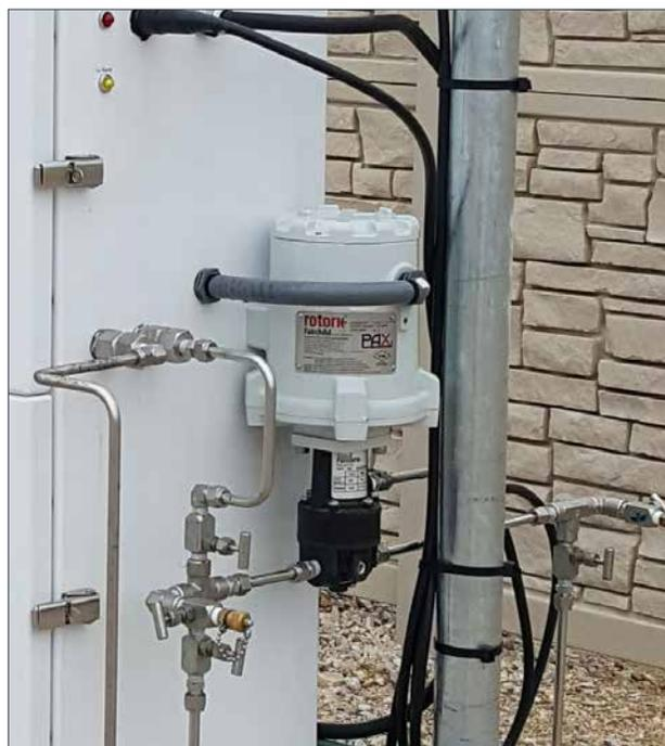
PAX1 instalado na estação, controle remoto de pressão movido a energia solar. Baixo consumo de energia, comunicação Modbus e modos de operação configuráveis permitem o controle automatizado da pressão de gás natural distribuída
